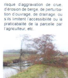
Embâcle à supprimer - source DDT
